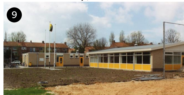
Bouw nieuwe kantine en kleedruimtes
